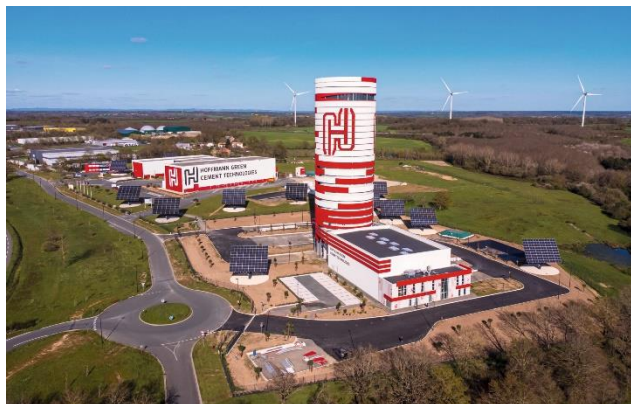
Usine Hoffmann Green Cement inaugurée le 12 mai 2023 en région Pays-de-la-Loire
