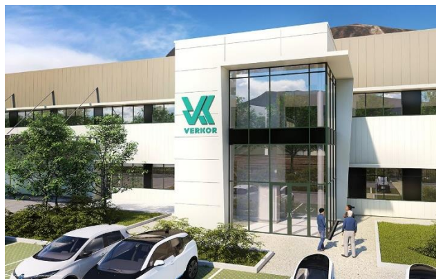
Usine Pilote Verkor inaugurée le 28 juin 2023 en région Auvergne-Rhône-Alpes
